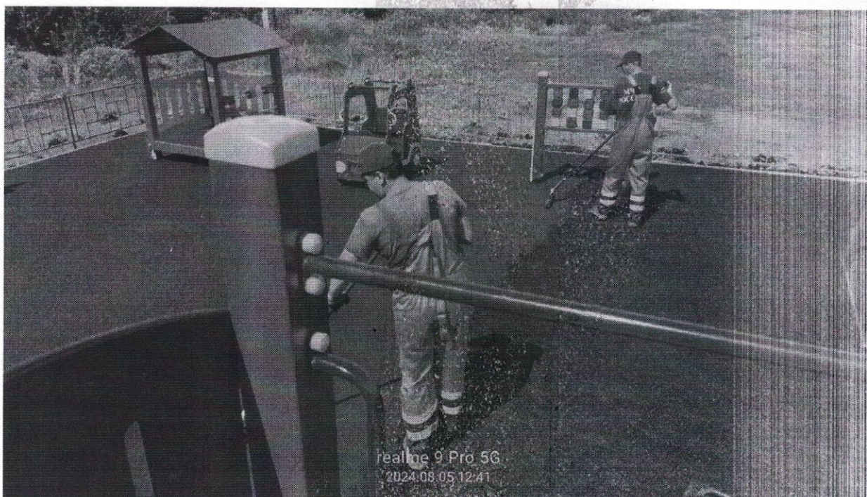
11. Уложено бесшовное покрытие из резиновой крошки толщиной 30мм.
