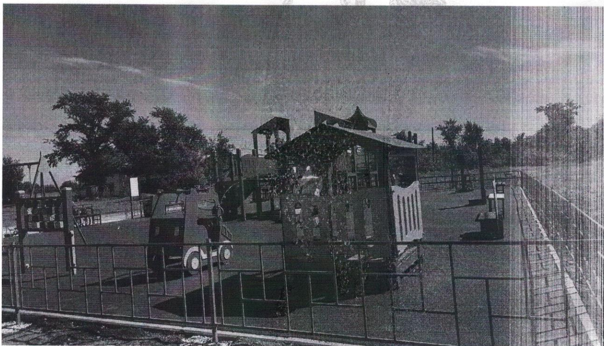
11. Уложено бесшовное покрытие из резиновой крошки толщиной 30мм.
